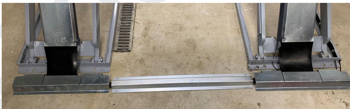
Täckplåt vid varje plattform och en täckplåt mellan plattformarna.
